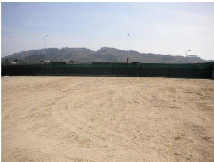
Fotografia 1 - Local para o Estaleiro Principal
